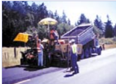
Fig. 0.4. Extendido y compactación de una mezcla bituminosa en caliente.
