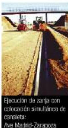
Zanja con colocación simultánea de conductos eléctricos
