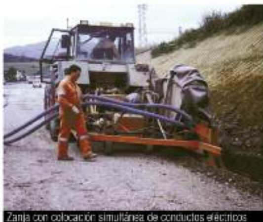
Zanja con colocación simultánea de conductos eléctricos
