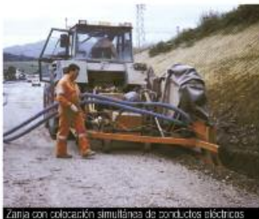
Zanja con colocación simultánea de conductos eléctricos
