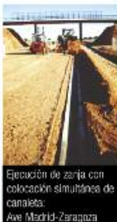
Zanja con colocación simultánea de conductos eléctricos
