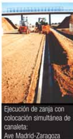
Zanja con colocación simultánea de conductos eléctricos
