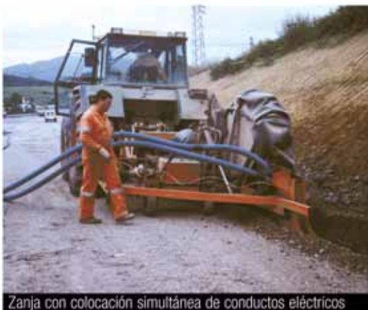
Zanja con colocación simultánea de conductos eléctricos
