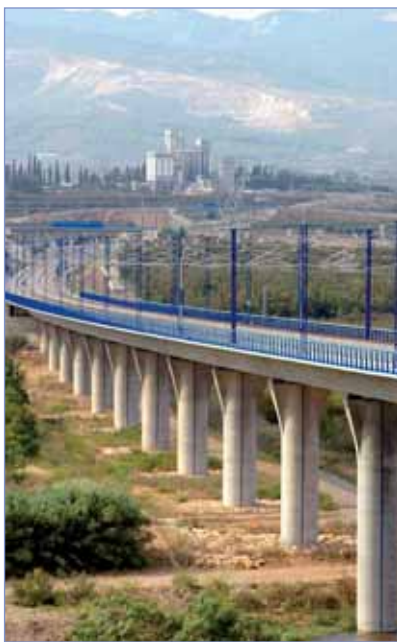
Viaducto sobre el río Francolí. Situado en la cuenca del río Francolí, importante nudo de comunicaciones viarias y ferroviarias del entorno norte de Tarragona; este tramo de 7 km de longitud constituye la vía de conexión directa entre el Corredor Mediterráneo y la LAV Madrid-Barcelona-Frontera Francesa en la dirección Valencia-Lérida
