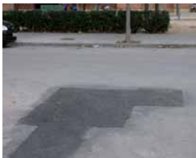
Nº 4: Detalle de relleno localizado. Precorte y zona de solape de 20 cm por cada lado.
