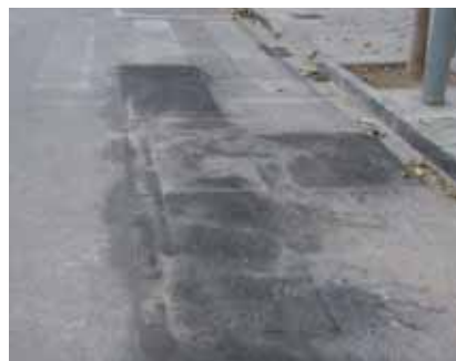
Nº 3: Detalle de terminación en juntas refino con arena fina.
