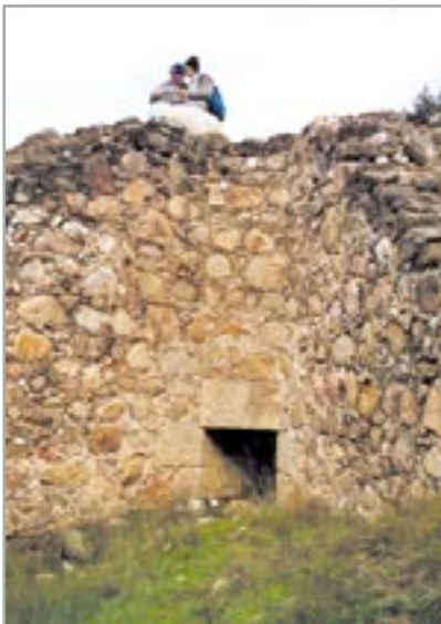
Canal de Guadarrama, paso sobre arroyo
