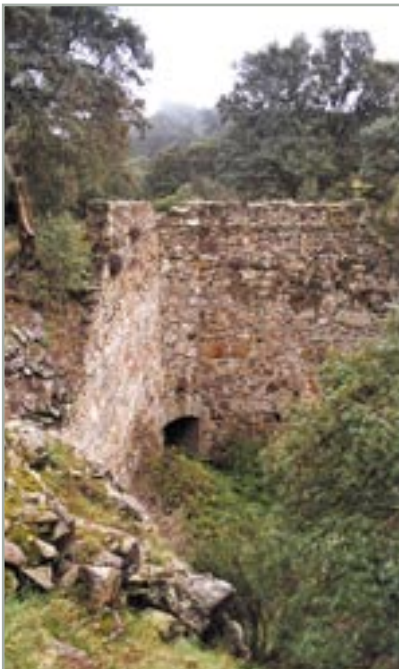
CANAL DEL GUADARRAMA Paso sobre arroyo
