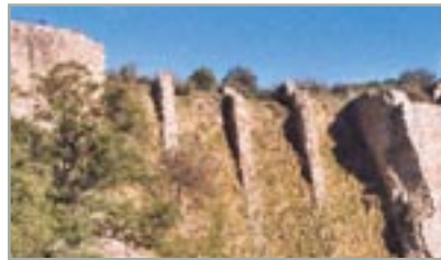
Presa del Gasgo aguas abajo
