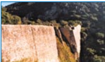
Presa del Gasgo aguas abajo
